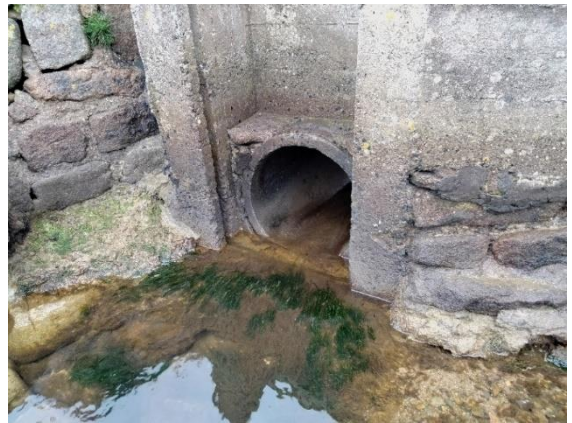
Buse Landrellec amont
